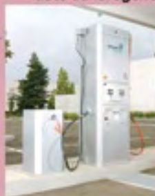
■ Pompa per rifornimento auto ad idrogeno
